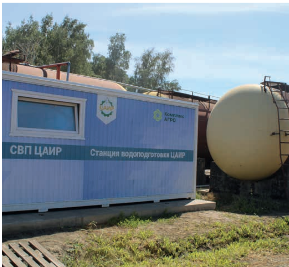
Блочно-модульная станция водоподготовки и очистки воды окупилась за один сезон
