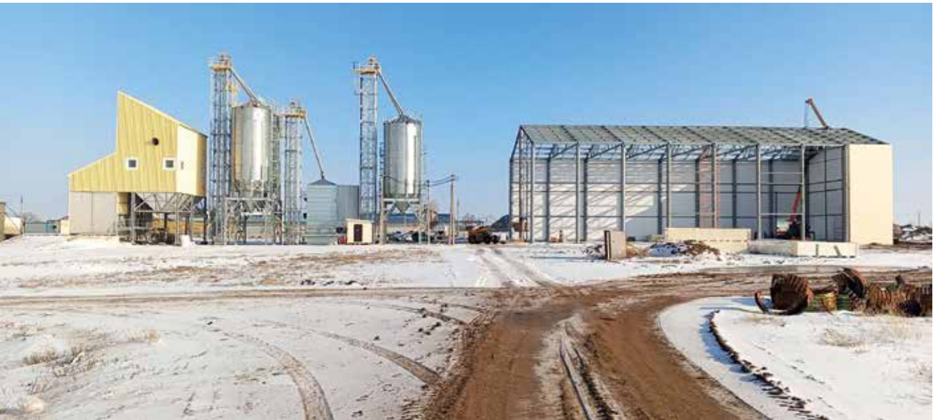
Строительство семеноводческого комплекса в КФХ Цирулёв Е. П.
